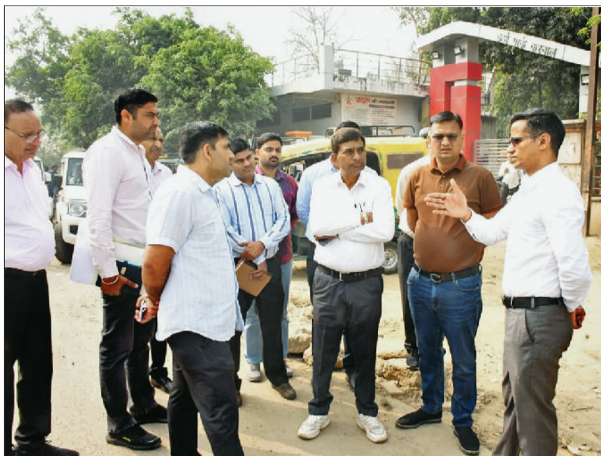
करनाल। एलिवेटेड पुल निर्माण कार्य का निरीक्षण करते उपायुक्त उत्तम सिंह।
